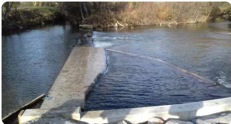
Travaux conduits en 2017 pour la mise en place d'une passe à poissons de type "pré-barrage": création à l'aval de l'obstacle d'un grand bassin qui fractionne la chute à franchir, aménagé dans son fond de façon à dissiper l'énergie de l'eau pour créer des zones de repos pour les poissons.
