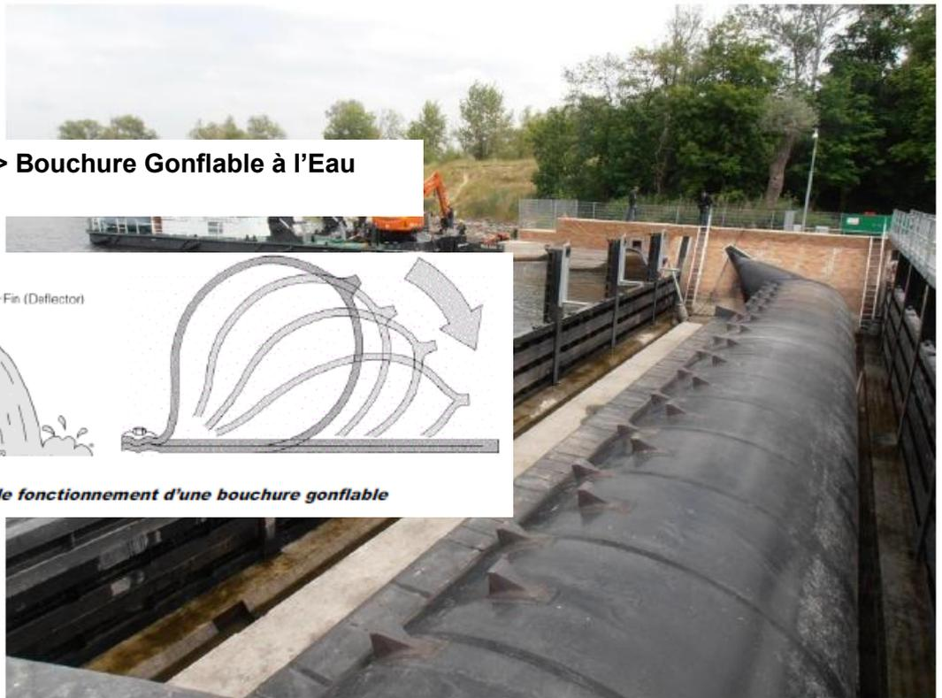
Fig. 4. Exemple de barrage gonflable à l'eau : Bahnitz Wehr (Allemagne) [2/2]
