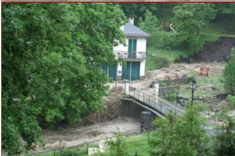
*Pendant la crue, le bâtiment constitue un point dur/saillant, qui fait défecteur et accentue l'érosion du pied de versant – la passerelle d'accès ne semble pas en charge – source D.Platon, CNRS/Géode*
