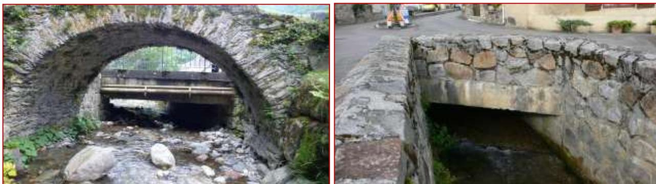
Dans la traversée urbaine, les cours d'eau sont souvent endigués (murs, etc.), ce qui engendre d'autres configurations propices à une mauvaise évacuation des crues. C'est notamment le cas lorsque la section d'écoulement, augmentée par l'endiguement longitudinal, précède un ouvrage sous-capacitaire, qui ne pourra entonner le même débit.
