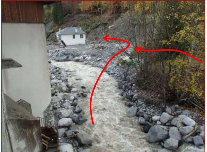
Les dépôts grossiers, en amont du bâtiment, proviennent en partie de l'érosion du versant et indiquent le rôle d'obstacle joué par lui - source D.Platon, CNRS/Géode
