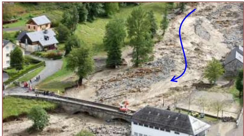
A leur tour, ces dépôts ont pu accentuer les débordements ou la mobilité latérale, en provoquant un brusque encombrement du chenal d'écoulement et, parfois, favoriser ou provoquer le contournement de l'ouvrage.
