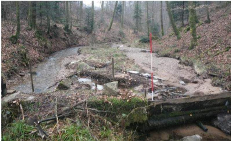
Photo 11 : Blocage des matériaux transportés par un ouvrage transversal dans une zone de charriage important (amont du Côney)
