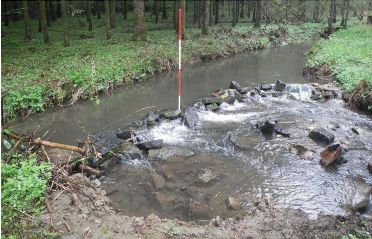
Photo 6 : Barrage précaire sur le ruisseau de Hautmougey, sert à alimenter le bras d'alimentation du canal
