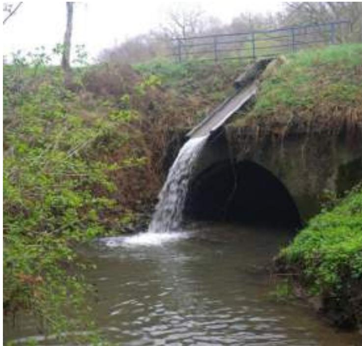
**Photo 5 : Trop plein du canal se déversant dans le ruisseau de Hautmougey, qui passe lui-même sous le canal pour se jeter ensuite dans le Côney**
