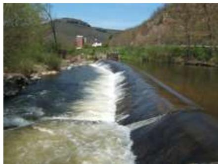
Le blocage des sédiments génère un déséquilibre du profil en long du cours d'eau en érodant le lit en aval de l'obstacle. Une fois le seuil comblé il devient transparent aux sédiments mais la chute d'eau continue à creuser une fosse en aval.
