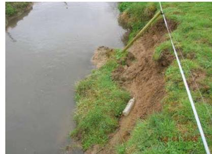
Berges du Crinchon et de la Scarpe dégradées par la mise en place de pales-planches ou par le piétinement des berges/ érosion
