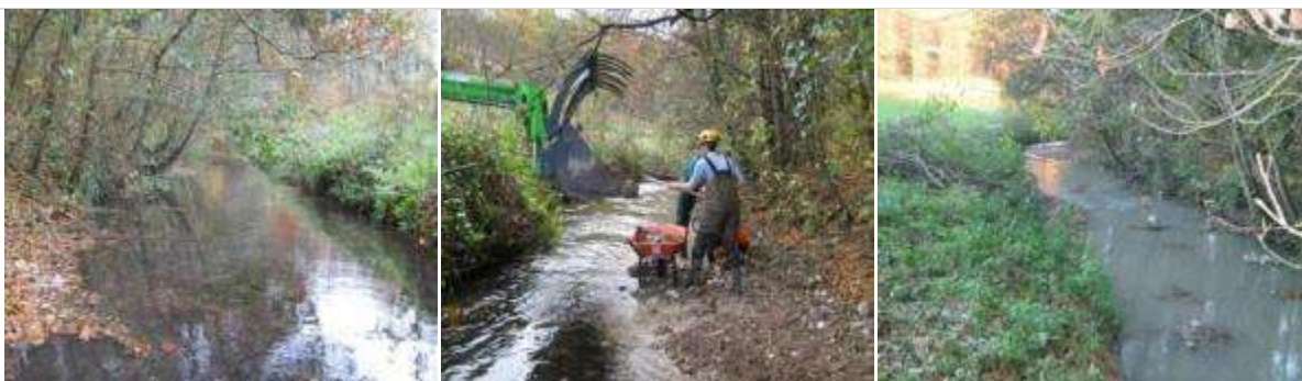
Exemple de recharge en granulats par banquette sur la Remberge (37) - Photos : Fabien Languille
