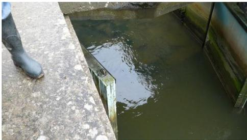
C'est un ouvrage de porte à flots, destiné à limiter l'intrusion d'eau de mer dans la basse vallée de la Slack, en cas de fortes marées. Cet endroit marque la fin du canal Napoléon.
