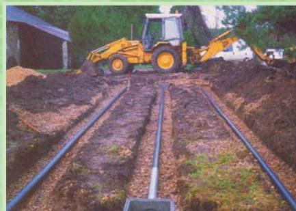
Mise en place d'un système d'assainissement autonome de type "tranchées d'épandage"
