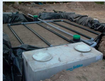
Réhabilitation d'un dispositif d'assainissement autonome
