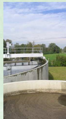
Traitement des eaux usées
