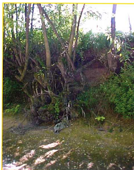
Erosion des berges à St-Maurice-de-Rémens
