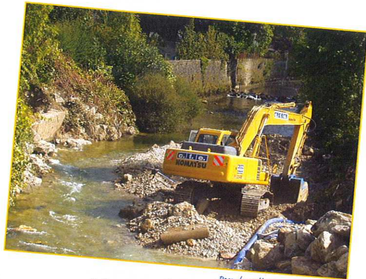
Pose du collecteur de St-Rambert
