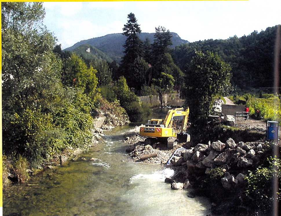
Pose du collecteur à Saint-Rambert-en-Bugey
