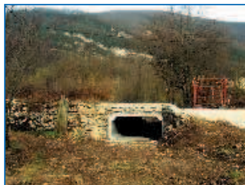
Dalot de décharge terminé
