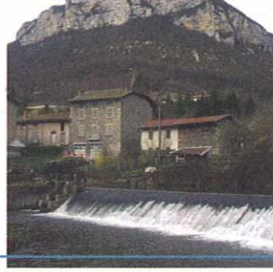
Aménagement du seuil d'Argis à réaliser en 2006
