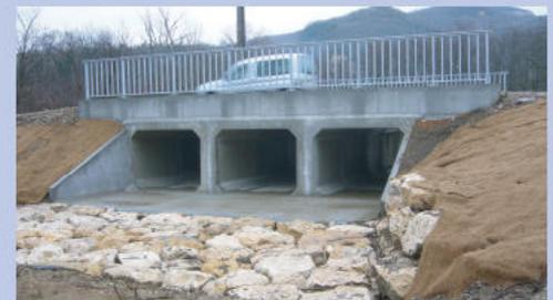
Construction d'un dalot de décharge pour l'écoulement d'une zone d'expansion de l'Albarine se mettant en eau lors de crue. Il a sécurisé la route de Bettant.
