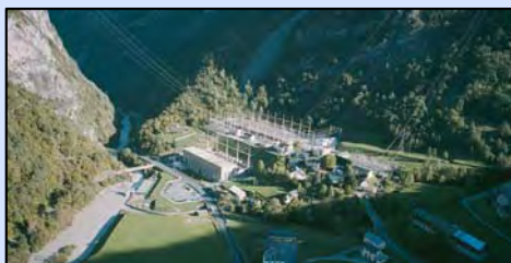
Centrale hydroélectrique de Pragnères
