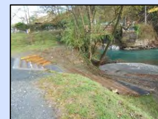
Pont de Tilhos
