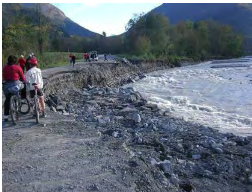
Dégâts causés sur la RD 913 à Beaucens (crue d'octobre 2005)
