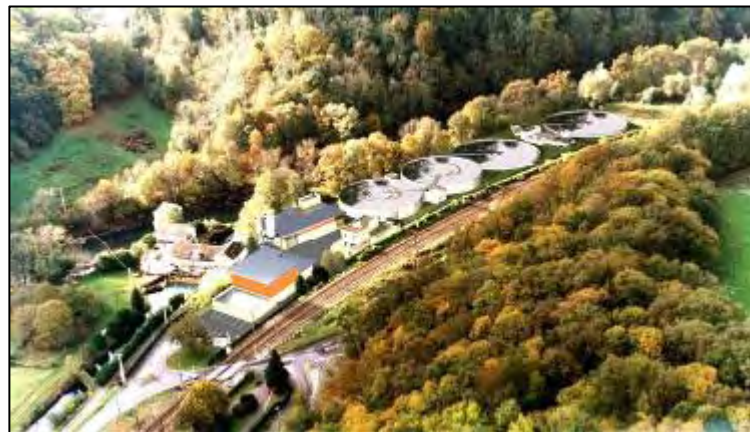
Nouvelle STEP de Lourdes (travaux achevés en 2005)
