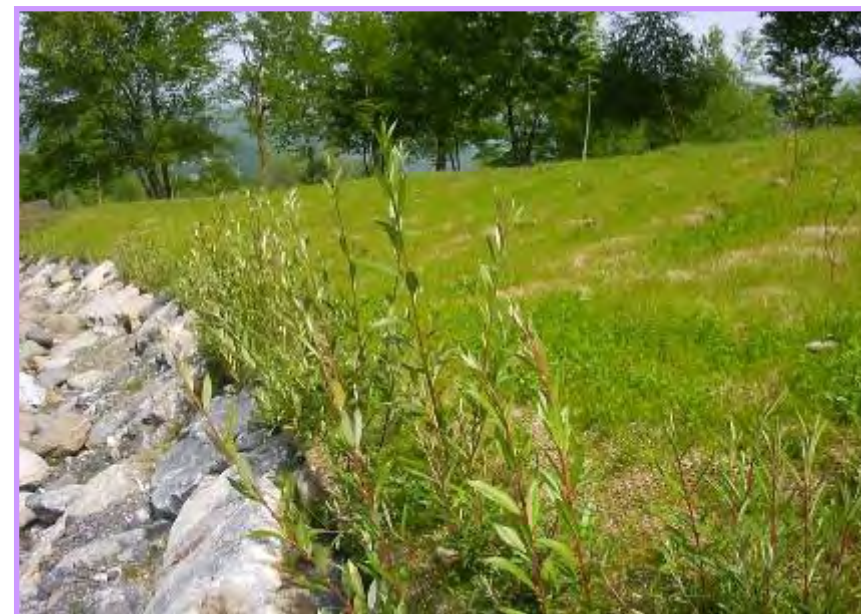
Protection contre les risques liés aux crues
