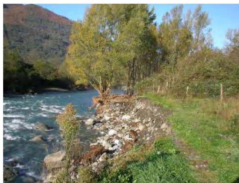
La décharge de Beaucens (rive droite du Gave de Pau)
