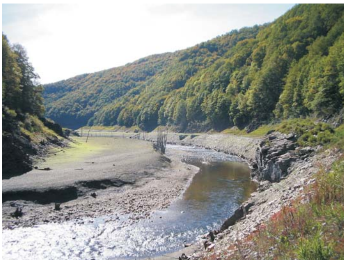
Abaissement de la retenue de Bort les Orgues le 10/10/05 - Ancien lit de la Dordogne au pont d'Arpiat
