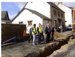
Travaux sur les réseaux d'assainissement de Merlines Eygurande en présence de Pierre CHEVALIER Président de la Communauté de Communes du Pays d'Eygurande le 23/05/05
