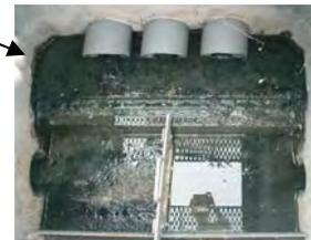
**Ce système de traitement des eaux blanches peut s'adapter à la région de la Haute-Dordogne, pour des petites installations et à condition d'isoler la surface du filtre. Une surface largement dimensionnée et le respect de l'alternance évitent le colmatage des filtres.**
