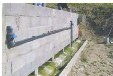
Les parois des filtres peuvent être construites au moyen d'éléments-types métalliques enduits d'une peinture adaptée contre la corrosion ou en béton banché adapté à l'acidité de l'effluent.
