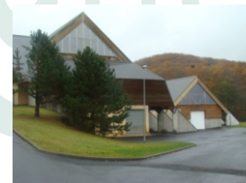
Station d'épuration du SIVOM Haute Dordogne le 05/11/08
