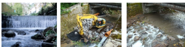
Seuil au niveau du pont de la Libération avant, pendant et après travaux Septembre 2008
