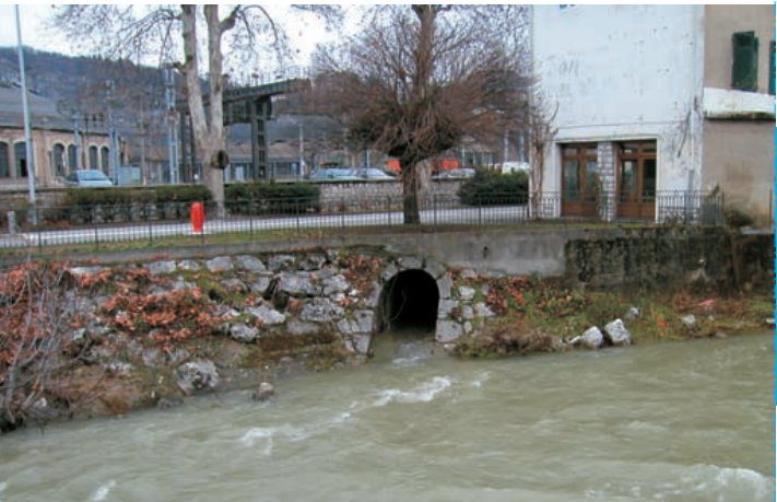
Déversoir d'orage Avenue de la Boisse (Chambéry)
