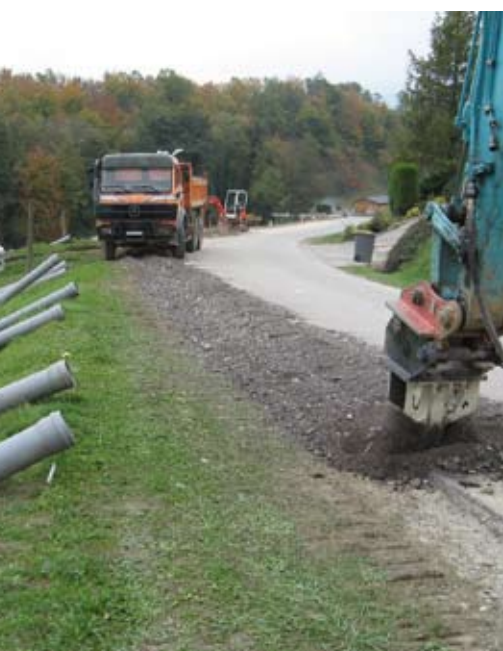
Travaux à St-Sulpice (Les Yvroux)
