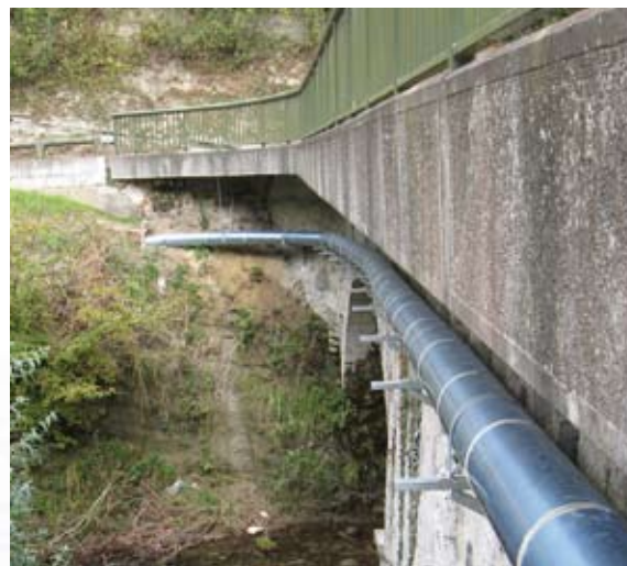
Descente des effluents du Montcel (Pont de la Verdasse)
