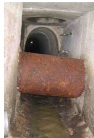
Réseau unitaire de Chambéry
