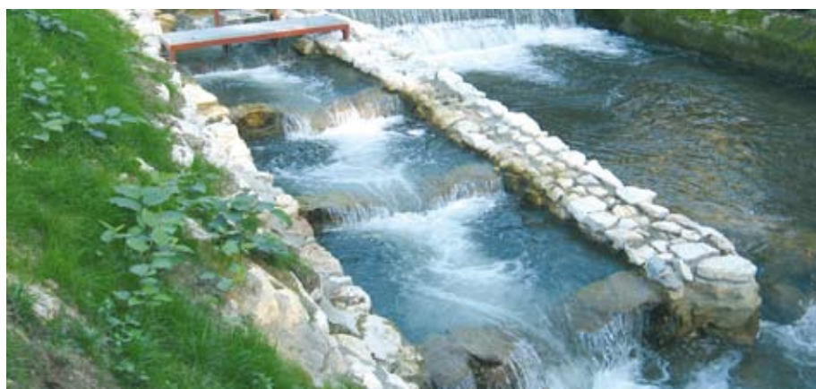
La passe à poissons du seuil de la voie SNCF
