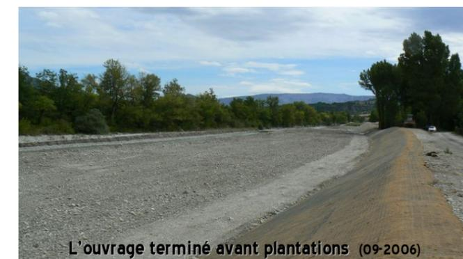
Devant les difficultés croissantes d'approvisionnement en blocs, nécessaires pour la réalisation de protection de berges en enrochements, cette technique représente une alternative qui pourrait être réutilisée sur le Buëch.
