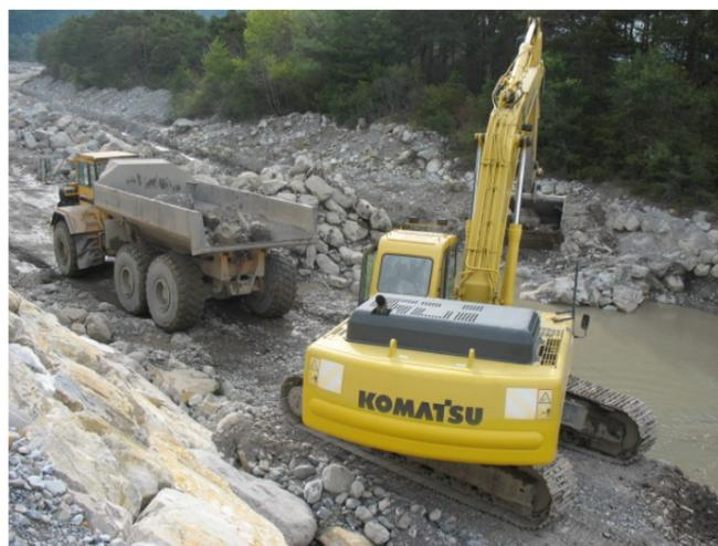
L'ensemble de ces travaux d'aménagement doit permettre de stabiliser le profil en long du lit du Buëch dans l'endiguement. Les habitations et les ouvrages : pont SNCF, décharge, traversée souterraine de la canalisation d'eaux usées, digues seront ainsi protégés de façon pérenne
