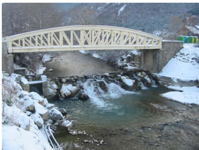
Photo 9 : Seuil du pont des Savoyons sur le Petit Buëch
