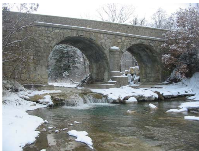
Photo 10 : Seuil du pont de la D148 à la Batie Montsaléon sur le torrent de Maraize
