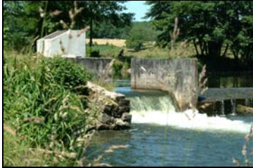
Barrage de Conflans-sur-Lanterne
