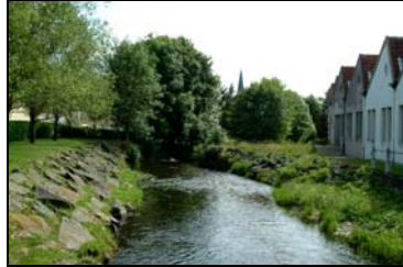
Enrochements au Val-d'Ajol
