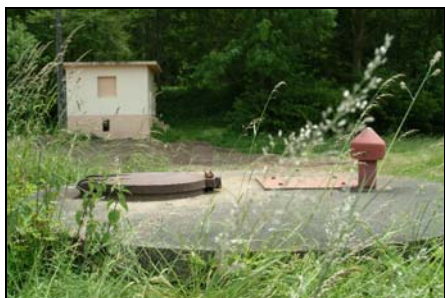
Puits de captage dans la nappe du Breuchin
