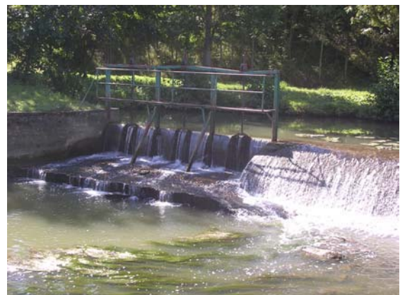
barrage et ouvrage en bon état.
