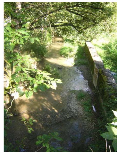
Les étéages réduisent la lame d'eau et le déplacement des poissons (Avant Dheune)
