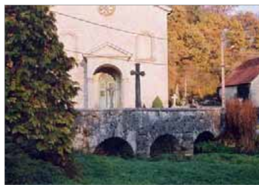
Pont de Courcelles
