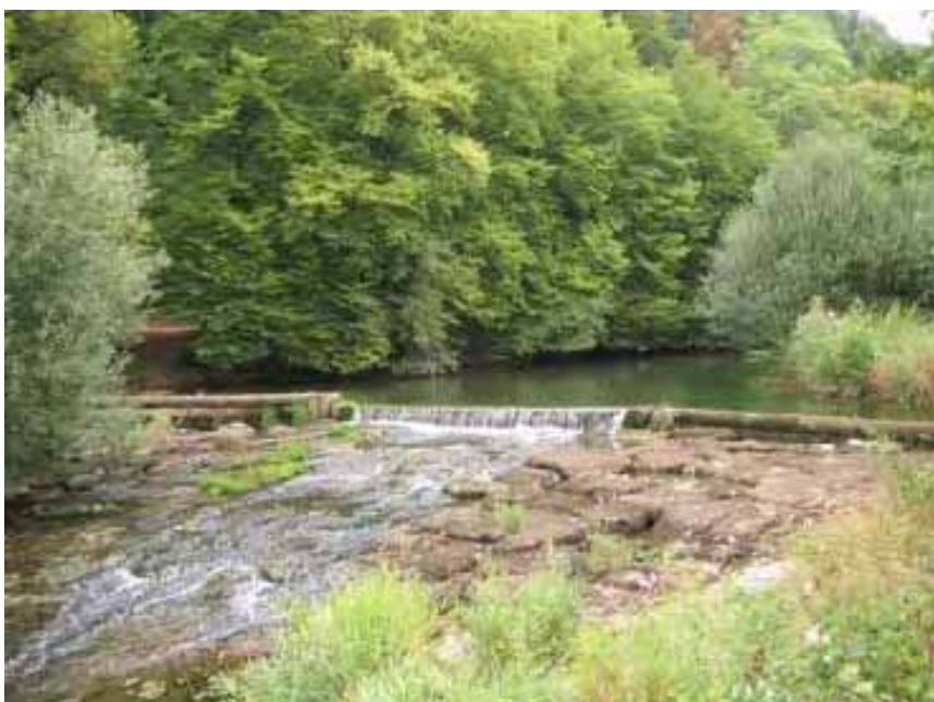
Seuil infranchissable sur l'Allaine en aval de Porrentruy Crédit photo CSD
