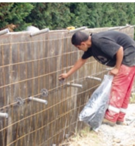
Un muret de 700 m de long et de 1,80 m de haut devrait protéger les riverains des crues du Garon.
