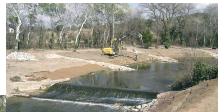
Travaux de stabilisation des berges de part et d'autre du Seuil de Gordes en mars 2005
