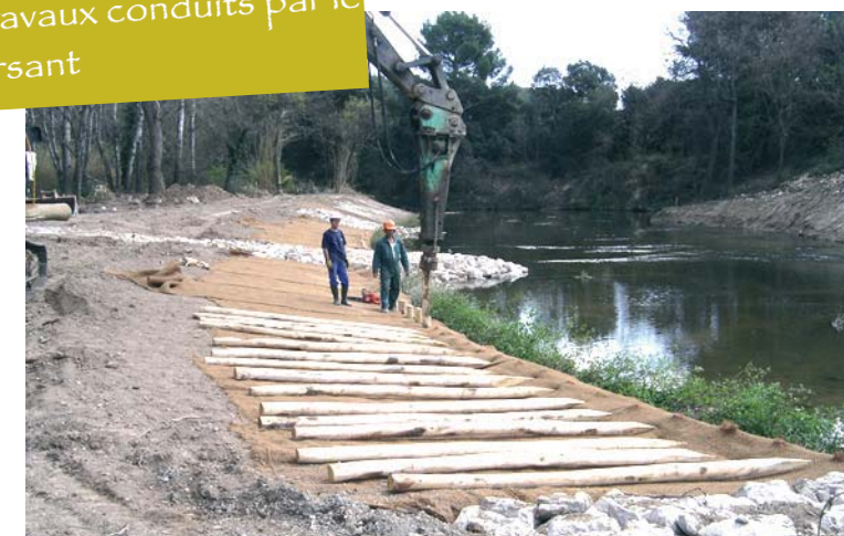
Travaux de stabilisation des berges de part et d'autre du Seuil de Gordes en mars 2005
