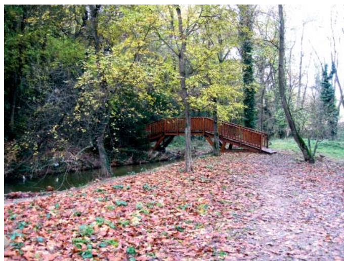
Aménagement d'une passerelle sur la Luyne à Gardanne
