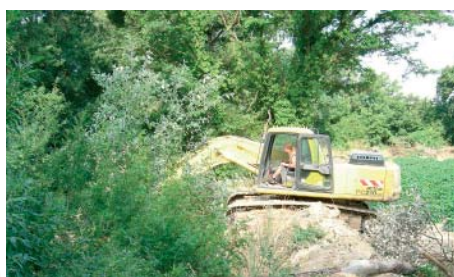
Démarrage des travaux
