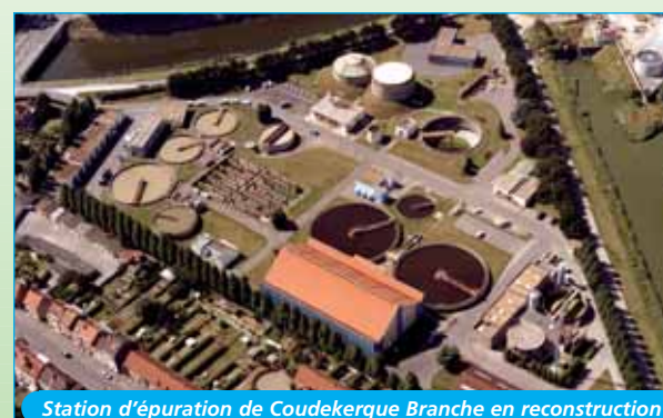
Station d'épuration de Coudekerque Branche en reconstruction
