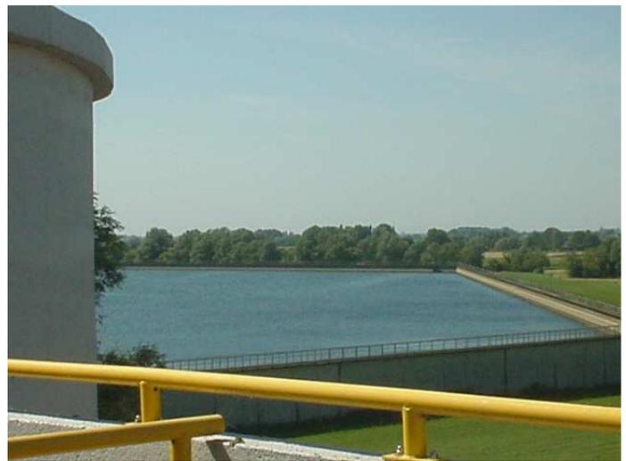
L'installation du Blankaart date des années 60-70. Un grand bassin de stockage - appelé bassin d'épargne - de forme octogonale est situé en rive droite de l'IJzer. Il couvre environ 60ha et stocke 3 millions de m<sup>3</sup> ! Il est alimenté par 6 pompes qui pompent à la fois de l'eau des polders du Blankaart mais aussi de l'eau de l'IJzer. Globalement l'eau traitée comprend pour 80% d'eau de l'IJzer et pour 20% d'eau des polders mais cela peut varier.
