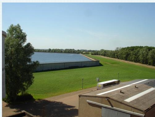
*Une partie des installations du Blankaart avec le « bassin d'épargne » qui stocke l'eau de l'Yser avant de la traiter afin de la potabiliser*
