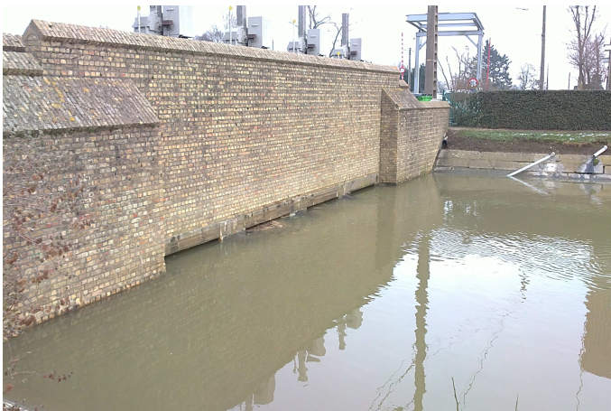
Ecluse et barrage de Fintele
