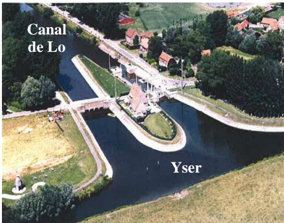
Ecluse et barrage de Fintele – by-pass des eaux de l'Yser via le canal de Lo
