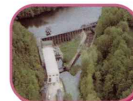
Barrage de LROB, EDF
