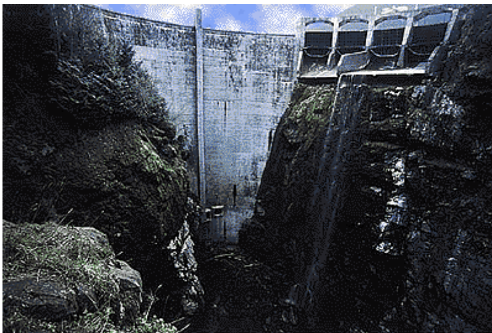
Figure 4 : Barrage de Glines Canyon
