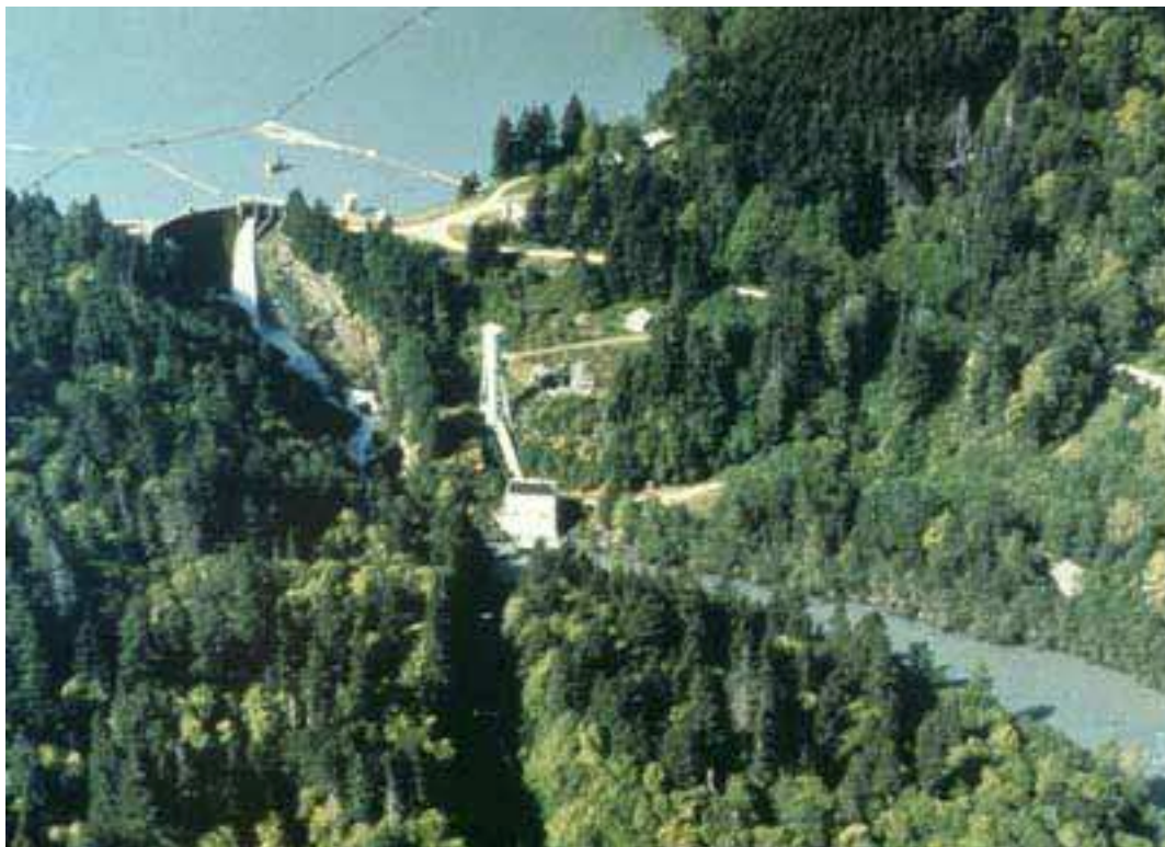
Figure 3 : Barrage de Glines Canyon
