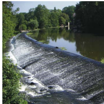
Barrage sur l'Orne
