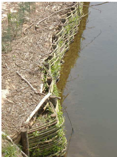
Photo 7 : Détail du tressage de saule (Source : BURGÉAP)
