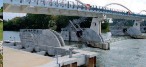
Barrage automatisé avec passe à poissons à Verberie
