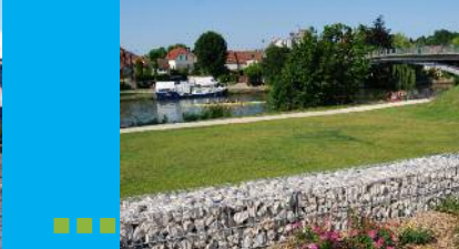
Aménagement contre les inondations à Choisy-au-Bac
