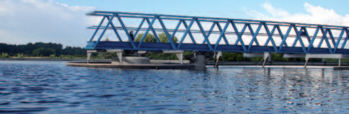
Station d'épuration à Brenouille
