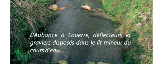
L'Aubance à Louerre, déflecteurs et graviers disposés dans le lit mineur du cours d'eau.
