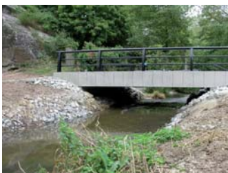
Nouveau Pont de la Roche-Jeannette (octobre 2008)
