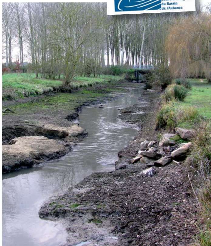
L'Aubance au Pont des Buttes Barrage abaissé Charcé-Saint-Ellier-sur-Aubance décembre 2008
