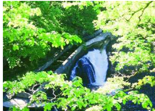
Le barrage EDF de Bussy, un grand barrage équipé d'une passe à poissons
