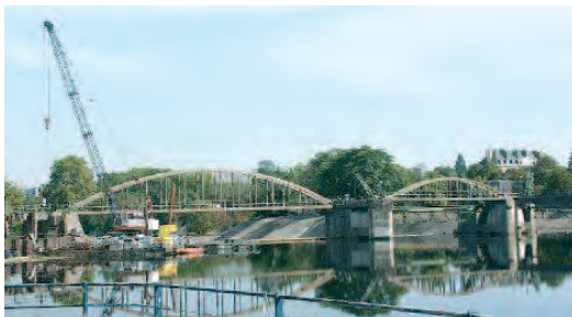
Le barrage de Châtelleraut, en cours d'équipement d'une passe à poissons (2004)
