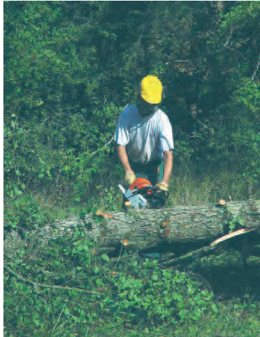
Travaux de restauration des berges
