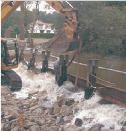
Le barrage soutenant la passerelle des Anguillons à Mimizan a joué son rôle pendant de nombreuses années pour la régulation du niveau de l'étang d'Aureilhan. Sous l'effet cumulé de la corrosion et de la pression de l'eau, il a du être remplacé l'an dernier par une construction provisoire afin de laisser le temps nécessaire aux études techniques.
