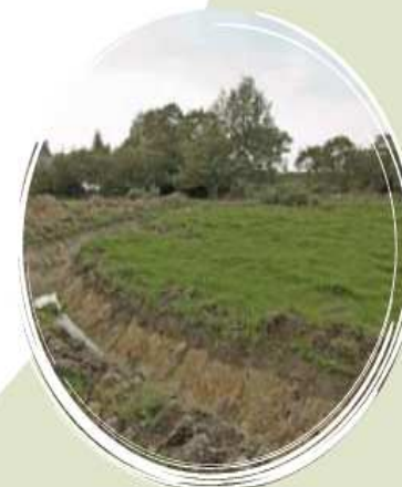
Travaux de drainage en zone humide
