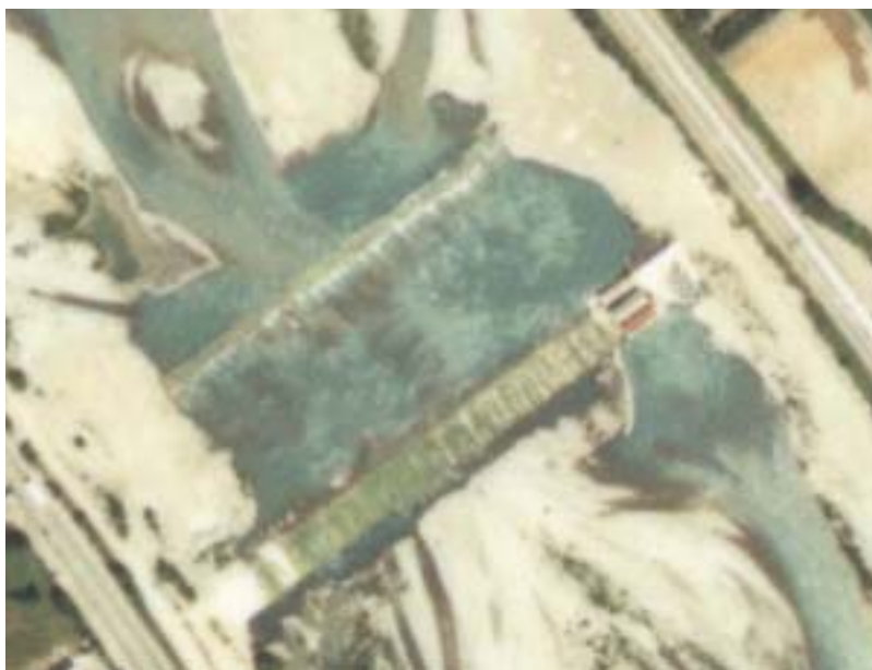
Seuil 10 et pré-seuil 10 situé 80m à l'amont – photo 1988 (DDA 06). Le pré-seuil 10 (rideaux de palplanches + enrochements en pieds) apparaît clairement.
