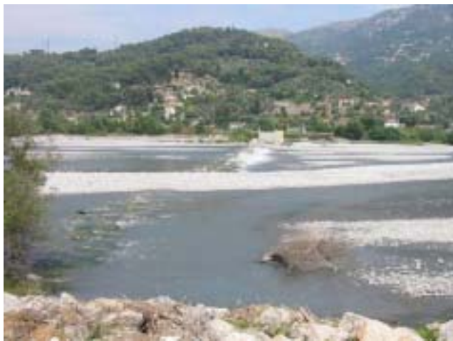
Seuil 10 – photo 2004 : le seuil est totalement engravé, la micro-centrale est arrêtée.
