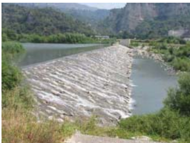
Seuil 8 – photo 2004 : l'engravement n'a pas encore atteint le seuil 8.
