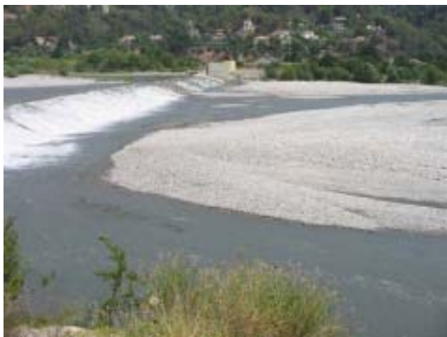
Seuil 9 – photo 2004 : la chute du seuil est réduite de moitié (2.50m au lieu des 5m initiaux) : l'abaissement pourrait être réalisé dès à présent.
