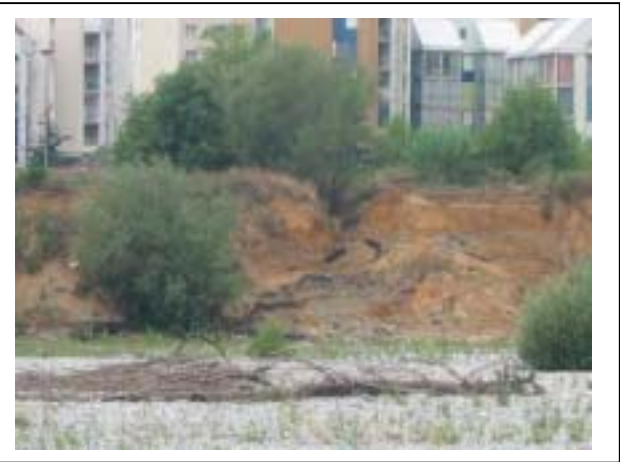
Digue Rive Droite à St Laurent du Var
