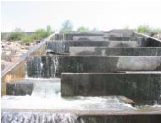
Figure 63 : Passe à poisson du seuil 4
