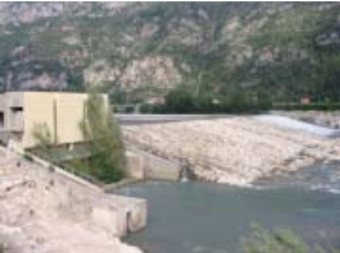
Micro-centrale seuil n°16 et passe à poissons
