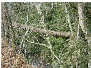
Le RIF de Mison, inaccessible avant les travaux
