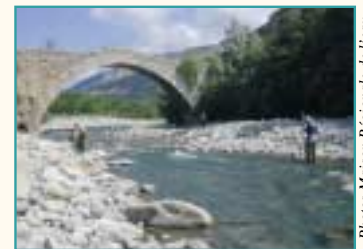
Photos Maison Régionale de l'eau
