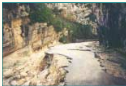
Dégâts suite à la crue de 1994
