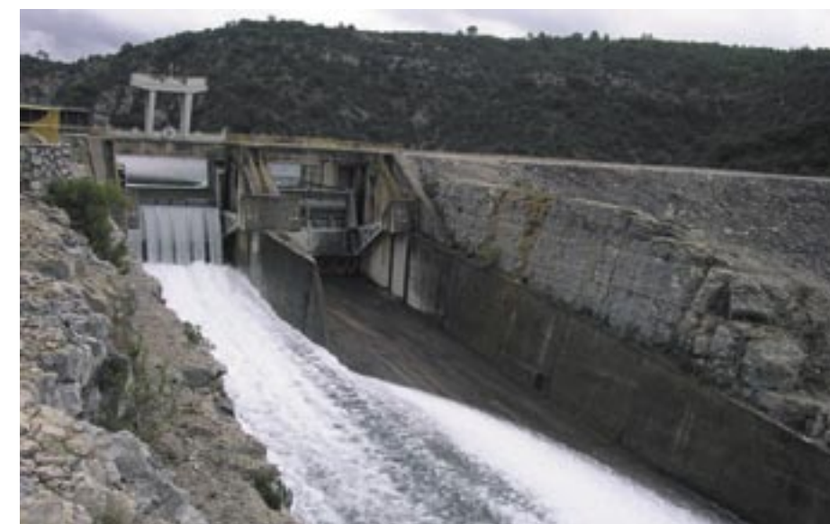
Lâcher à l'évacuateur de crue du barrage de Gréoux
