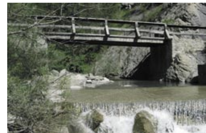
Seuil infranchissable sur la Chasse
