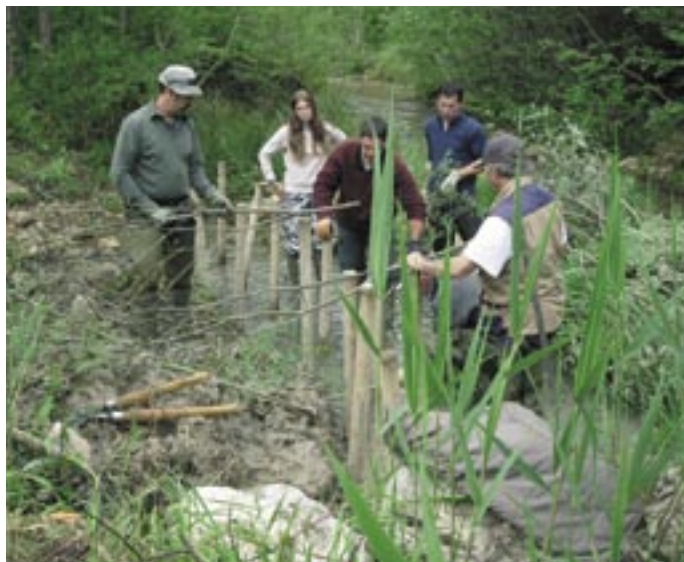
Réalisation d'une protection de berge en génie végétal
