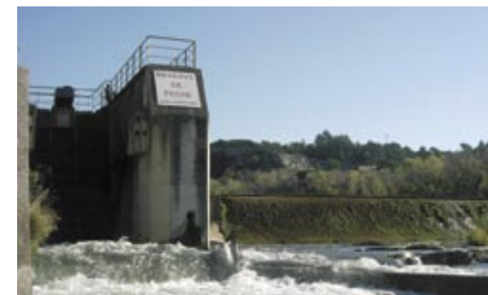
Vidange du seuil de Gréoux-les-Bains afin de favoriser la remontée des truites
